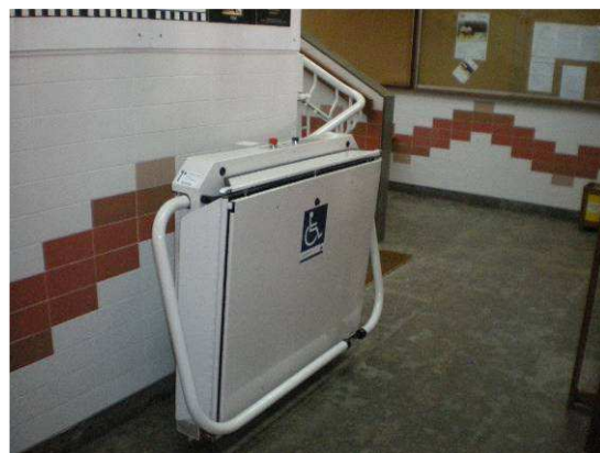
Plataforma elevatória aplicada na escada do bloco A
