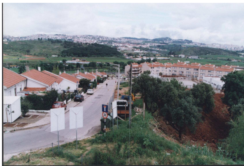
Figura 9 - Arruamento estruturante de acesso a todo o bairro, íngreme e sem saída.
