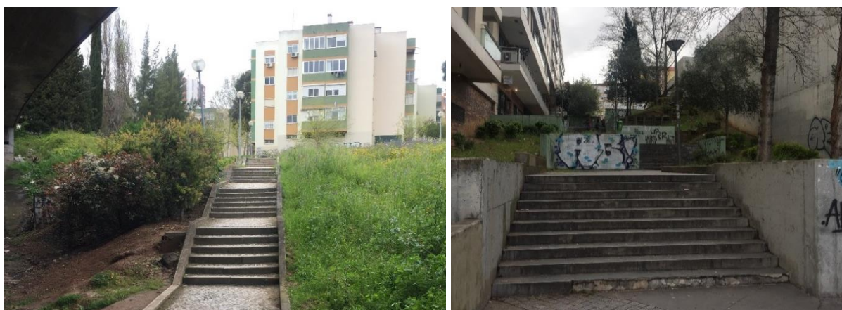
Figura 24. Locais suscetíveis para a implementação de calhas em escadaria em Odivelas
