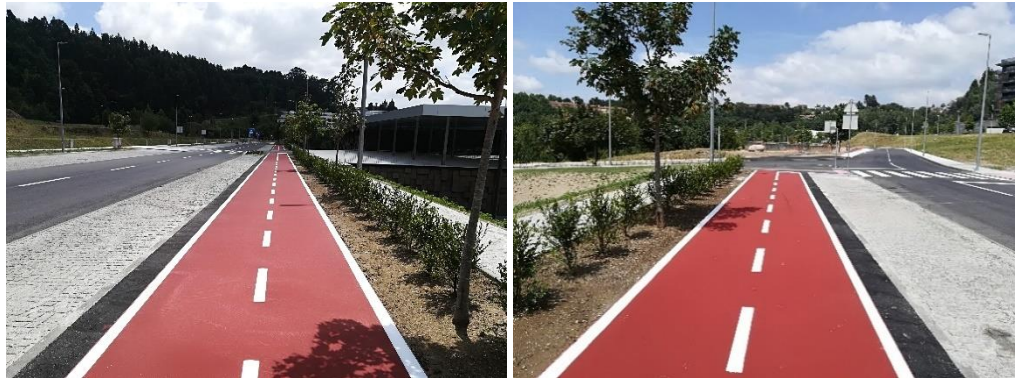
Figura 52. Imagem de referência da aplicação do pavimento betuminoso com revestimento slurry
