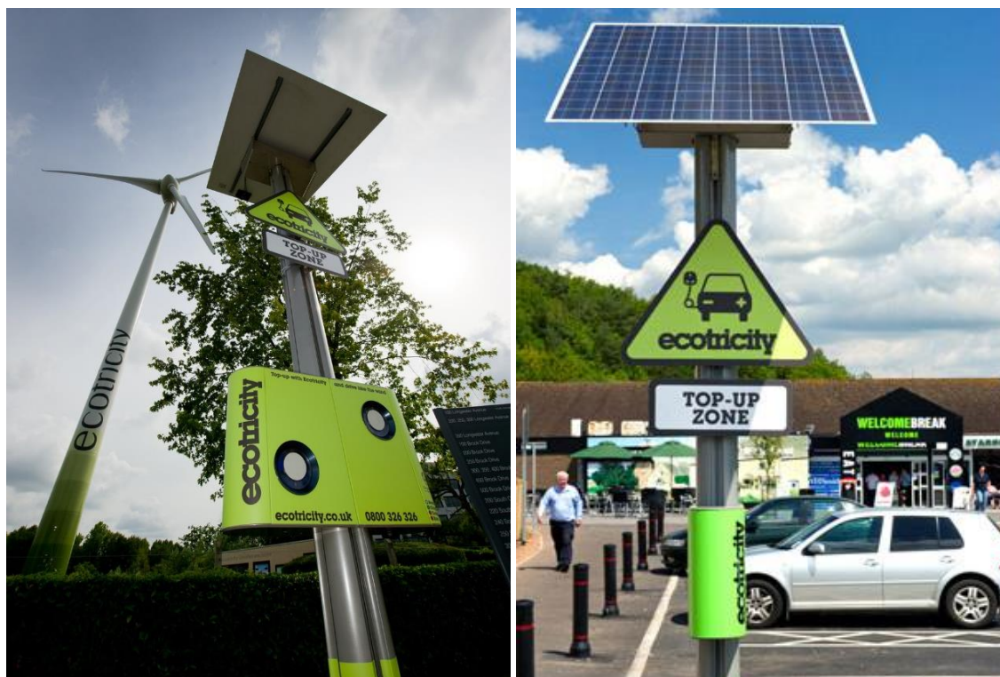
Figura 101. Postos de carregamento elétrico proveniente de energias renováveis – Reino Unido
