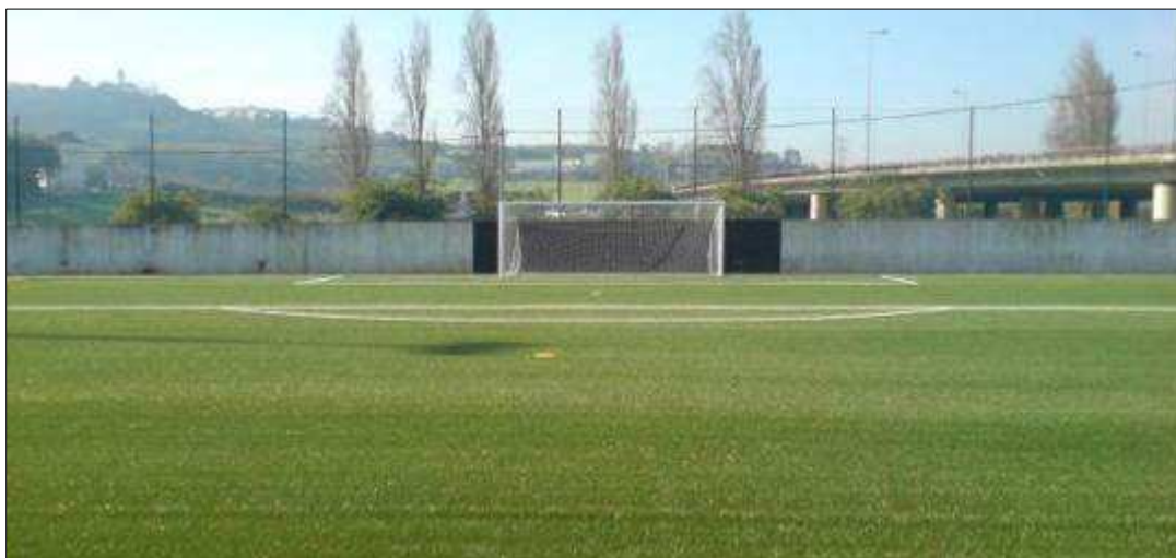
Após a intervenção
