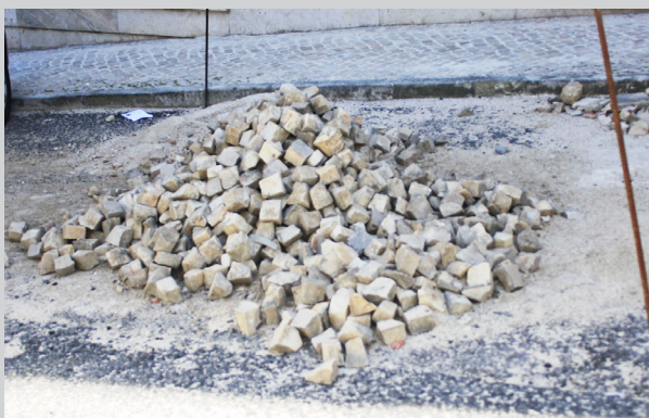
Substituição de um troço de 170m da conduta de abastecimento DN 110 da Rua Serpa Pinto, em Odivelas, obra levada a cabo no âmbito da empreitada generalista de Substituição de Condutas nos Concelhos de Loures e Odivelas, que tem um valor superior a € 120.000,00.
