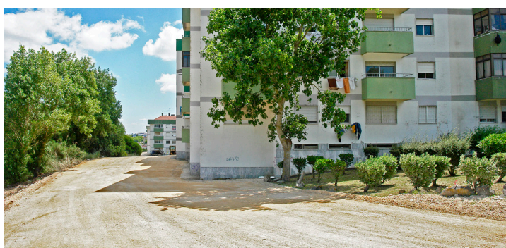
Pavimentação e reperfilamento das traseiras da Rua Dr. João dos Santos
