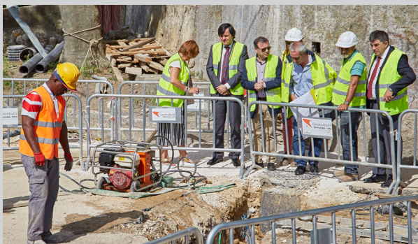
Execução de Coletor de Águas Residuais Domésticas em Caneças, junto às instalações da Rodoviária de Lisboa, um investimento superior a € 80.000,00
