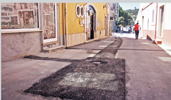
3.ª fase da Empreitada de Substituição de Condutas da Rede de Abastecimento em Caneças, um investimento de mais de € 320.000,00, que se junta assim à 1.ª fase já há muito em curso e que teve um investimento superior a € 310.000,00.
