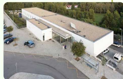
A Unidade de Saúde da Póvoa de Santo Adrião abriu portas a 2 de setembro.
