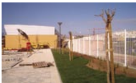
12 | Construção de duas obras significativas do PROQUAL: o Centro de Exposições e o Parque Urbano do Silvado.
