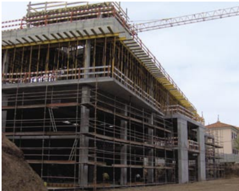
Estado avançado das obras do Centro de Exposições
