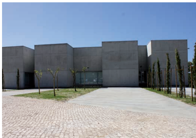
Construção da USF da Ramada a par e passo
