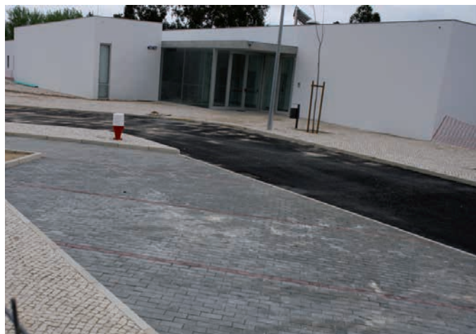
Construção da USF da Póvoa de Santo Adrião por etapas
