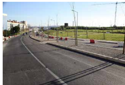
Av. das Acácias requalificada fev | 2013
