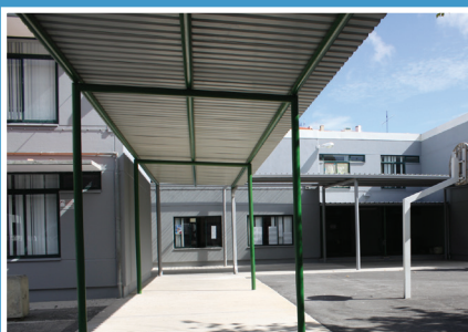
EB Rainha Santa, Odivelas Reparação da cobertura e paredes exteriores do edifício Investimento: 28.177,50 EUR
