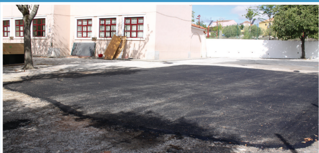
EB Mello Falcão, Pontinha, e EB António Maria Bravo, Odivelas Demolição de pré-fabricados Investimento: 11.437,57 EUR
