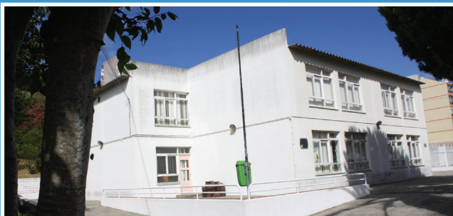
EB Maria Costa, Ramada Remodelação geral com substituição de cobertura Investimento: 123.715,10 EUR
