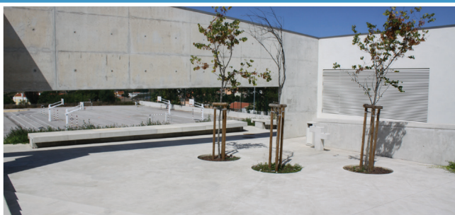
Escola Secundária de Caneças Substituição da cobertura do pavilhão gimnodesportivo Investimento: 9.925,73 EUR
