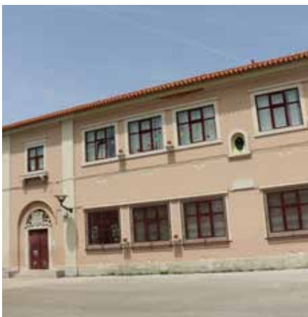
EB Quinta da Paiã, Pontinha Reparação pavimento exterior, rampa de acesso, telheiro da rampa, caldeiras das árvores, colocação equipamento lúdico
