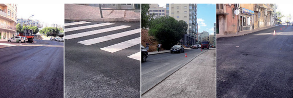
OBRAS na rede viária págs. 8 e 9
