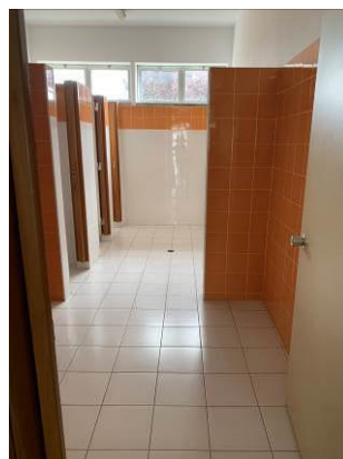
Instalações sanitárias bloco D
