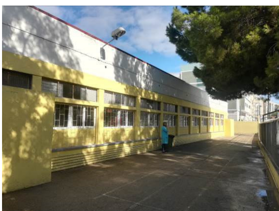
Bloco desportivo / Balneários
