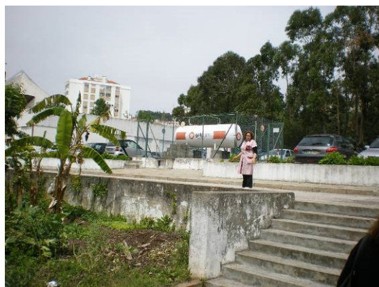
Depósito de gás
