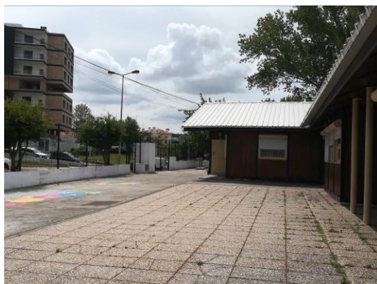
Edifício escolar e recreio
