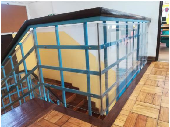
Guarda da escada interior
