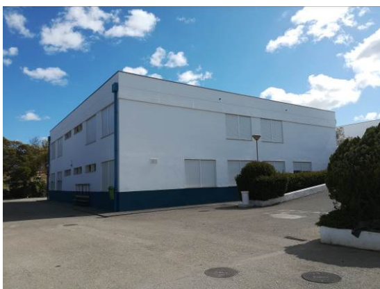
Bloco de aulas
