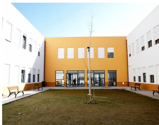
Área relvada entre blocos
