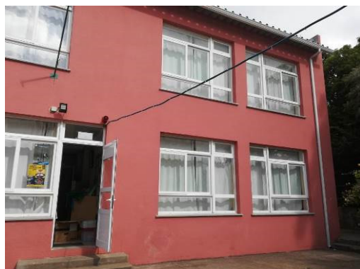
Bloco de sala de aulas
