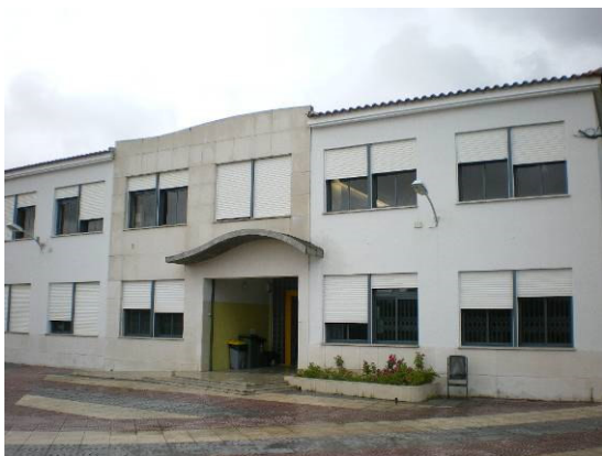
Edifício de aulas
