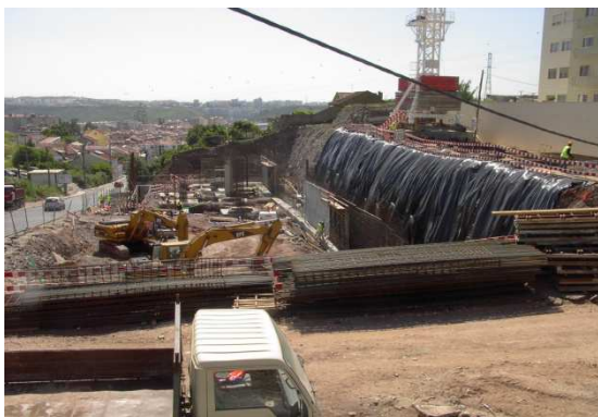
Fase de construção (fundações)
