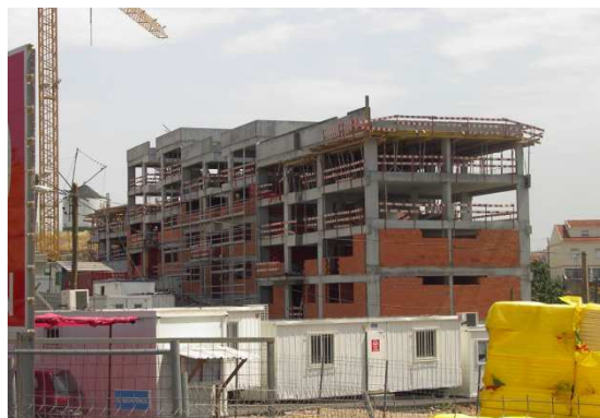
Fase de construção (edificado)
